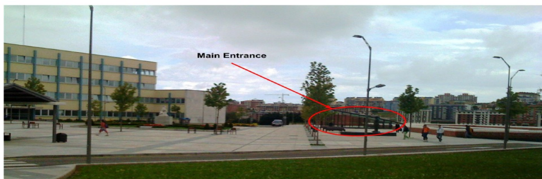
Figure 2. Laboratorios de I+D+i de Ingeniería de Telecomunicación building
